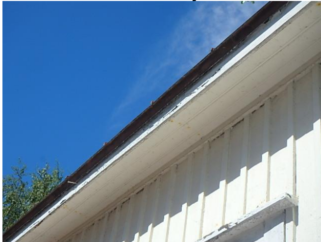
Sadevesikouru puuttuu
