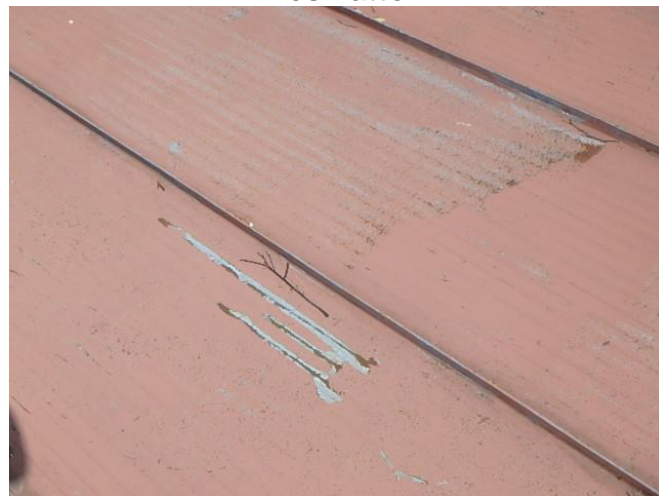
Maalihilseilyä, pintaruostetta
