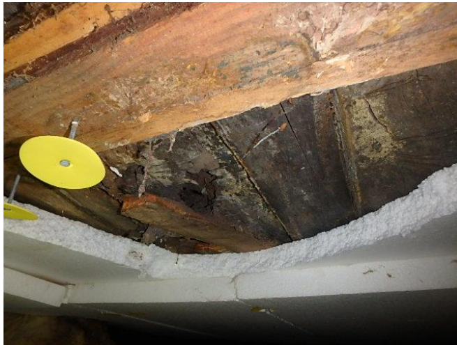
B-asunnon wc:n kohdalla kasvustoa sekä lahovauriota
