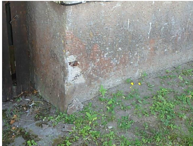
Paikoittain pieniä vaurioita
