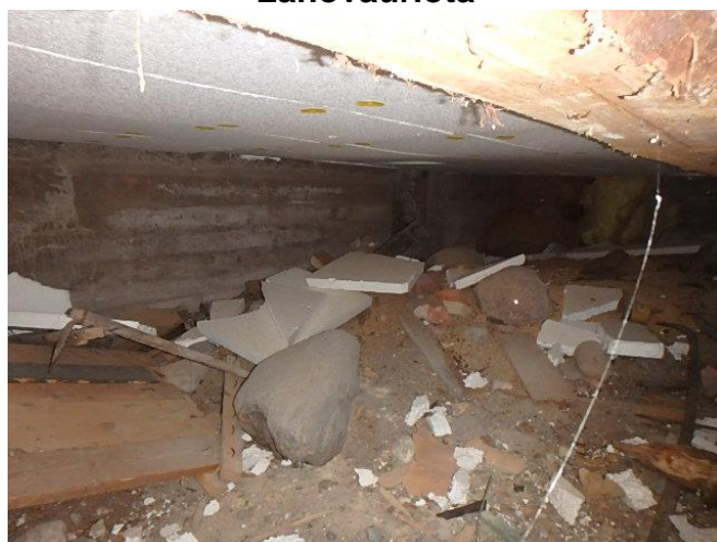
Alapohjassa paljon sinne kuulumatonta materiaalia
