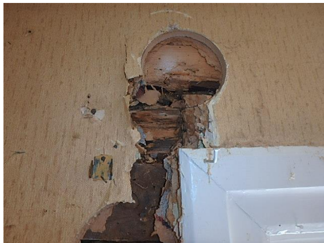
A-asunto oh, tarkistuskohta 4, lahovauriota
