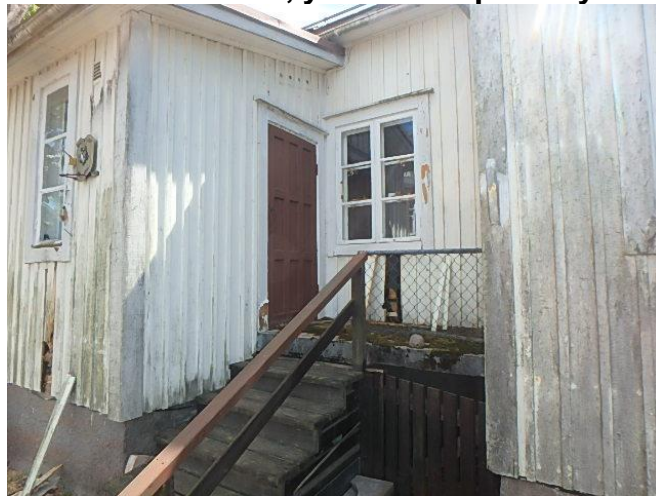
Sisäänkäyntien väli, tarkistuskohta 2
